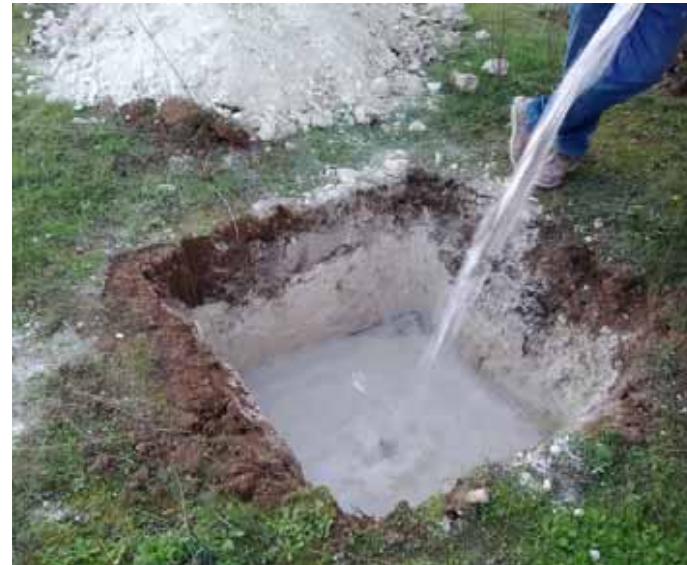
Riempimento del pozzetto P1
