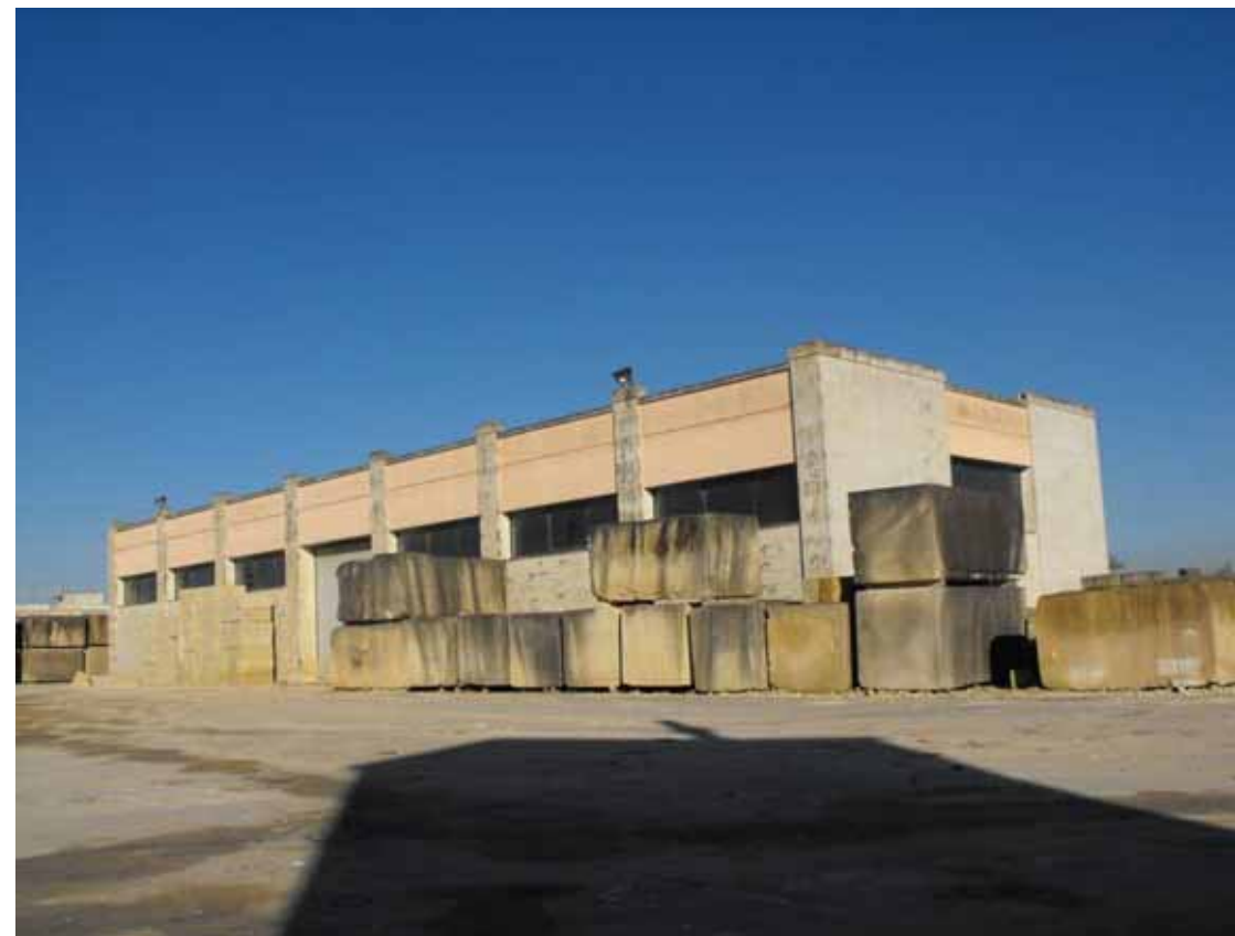
Foto 3.23 - Area di lavorazione e deposito blocchi in Pietra Leccese
